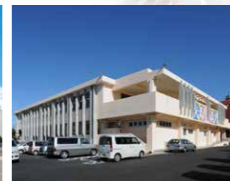
うるま市立立場小学校 屋内運動場
